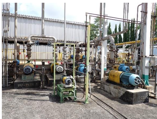
ภาพที่ 2-7 ปั๊มน้ำสำรองในระบบสูบน้ำ
