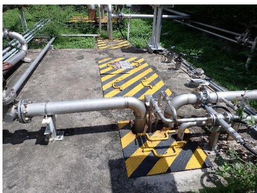
ภาพที่ 2-6 บ่อรวบรวมน้ำเสีย (Inspection Manhole)
