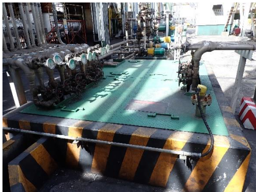
ภาพที่ 2-4 บ่อรวบรวมน้ำทิ้งจากการหล่อเย็นขนาด 12 ลบ.ม. (Hot Water Pond)
