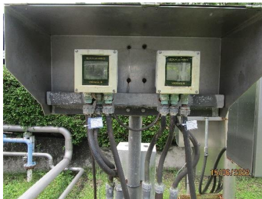
ภาพที่ 2-5 ระบบควบคุมค่าความเป็นกรด-ด่าง, ความขุ่น, อุณหภูมิ และปริมาณของแข็งที่ละลายน้ำได้
