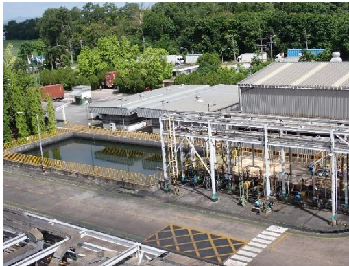
ภาพที่ 2-3 บ่อพักน้ำขนาด 4500 ลบ.ม.
