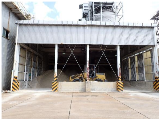
ภาพที่ 2-14 พื้นที่รวบรวมยิปซัมจาก ระบบกำจัดก๊าซซัลเฟอร์ไดออกไซด์
